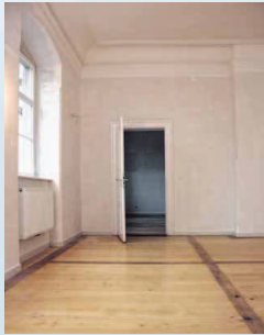
Vielfach wurden die alten Holzböden, wie hier in der ehemaligen Bürgermeistereiwohnung, freigelegt und restauriert.
