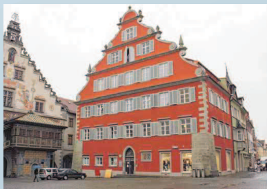
Innen und außen komplett saniert: das Neue Rathaus im Herzen der Insel. FOTOS (5): RUTH EBERHARDT
