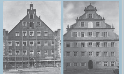
Das Neue Rathaus änderte im Laufe der Zeit sein Antlitz. So hatte der ursprünglich barocke Bau von ca. 1855 bis 1937 eine neugotische Fassade (links). Sie wurde im Jahr 1938 wieder barockisiert (rechts). FOTO: BAUARCHIV DER STADT LINDAU, ARCHITEKTURBÜRO MAY
